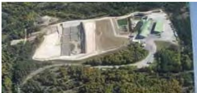
Figure 36 : Vue aérienne des installations du SDEE
