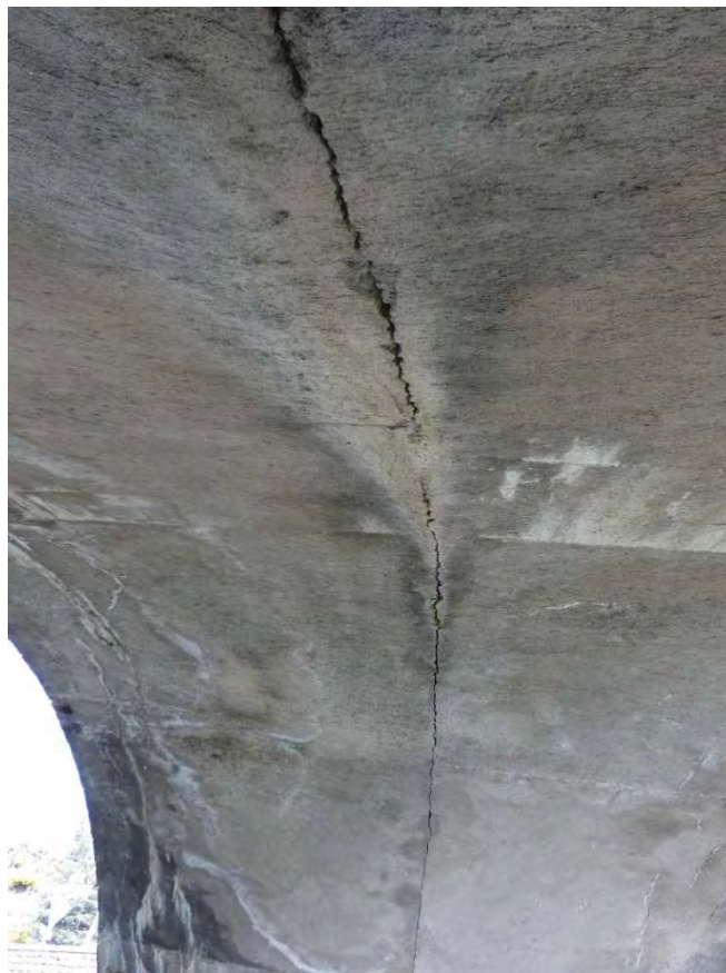
Voûte béton armé qui se délite Fracture voûte béton armé Date de publication : 12 novembre 2025
